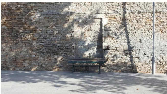
fig.21 Vieux mur derrière la Médiathèque
